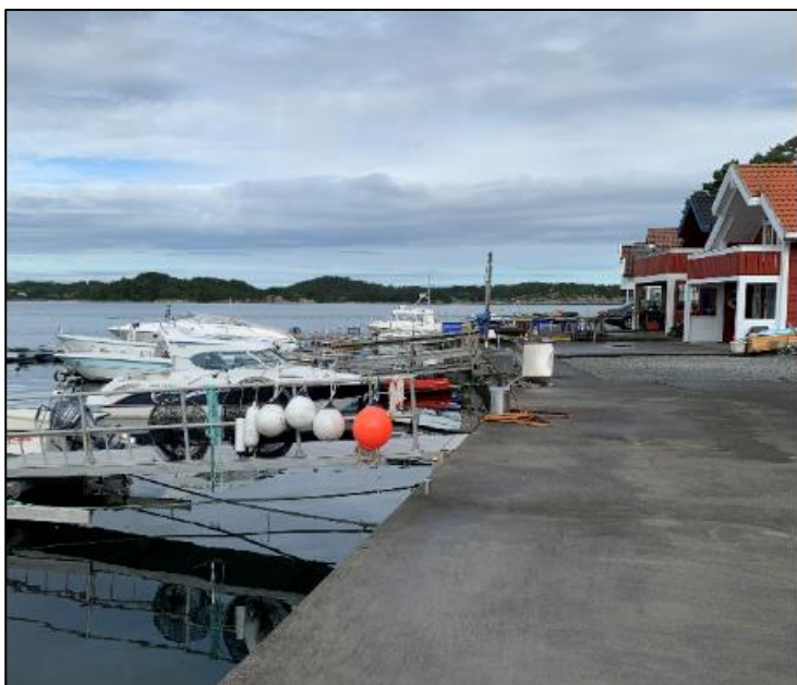
Figur 6 Eksisterande kai og småbåthamn
